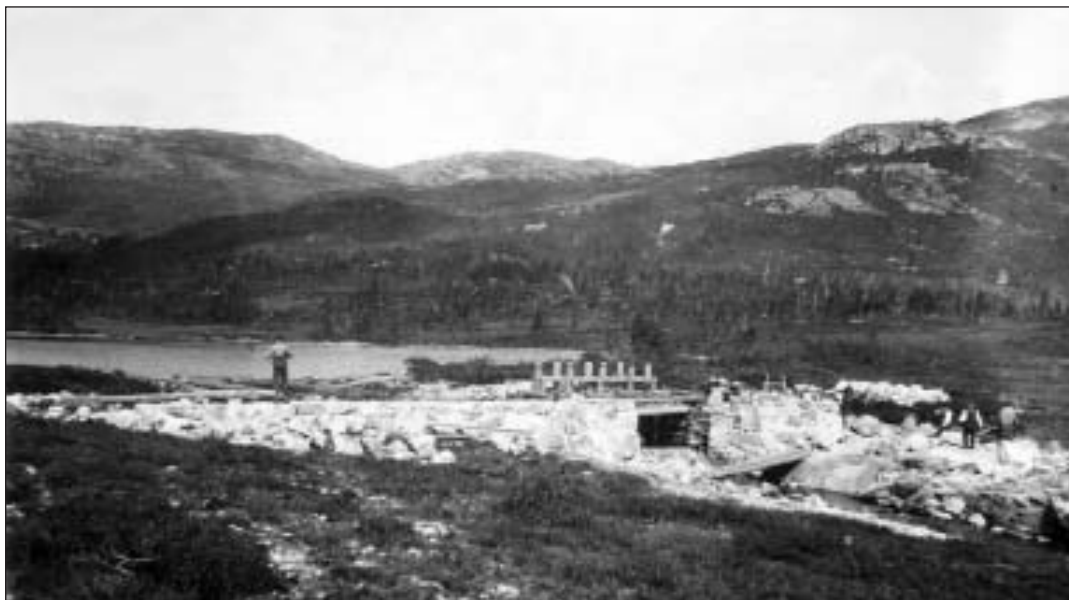
Bygging av ny Nordstul-dam. Vannet herfra ble brukt til fløting ned til Follsjø. (ØTBs arkiv)
