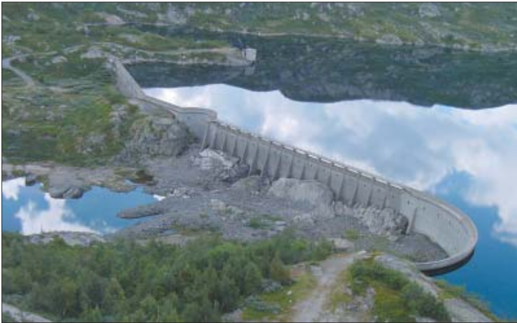
Grottedammen, inntaks- dam for Mår kraftverk. Dammen består av to platedammer og to bue- dammer. (Jack Hagen/ ØTBs arkiv)
