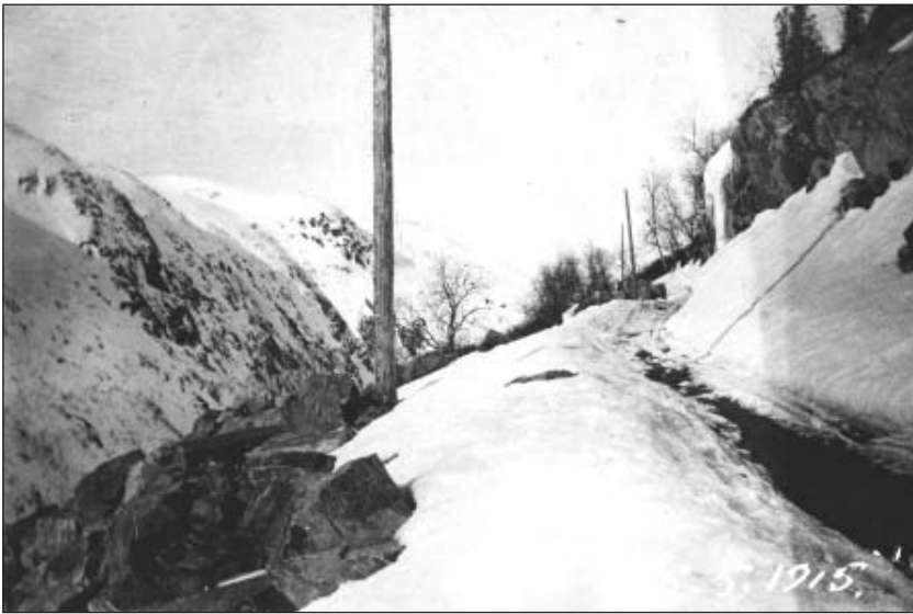
Rikulfbulia, en del av den 19 km lange vegen mellom Steinsbøle og Kalhovde. Vegene ble bygget i 1910, og bildet er tatt 5.5. 1915. (ØTBs arkiv)
