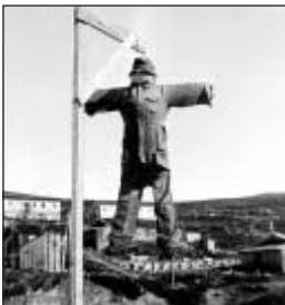
Fillemannen vaier fra Kalhovddammen i 1947 (?). Anleggsarbeiderne var ikke fornøyd med entrepenøren som ikke ga dem noen påskjønnelse for fullført arbeid. (Knut Skavlebø).
