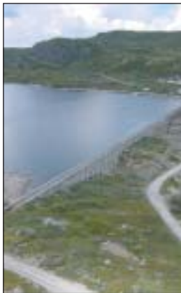
Kalhovddammen, en massivdam på 320 m. (Jack Hagen/ØTBs arkiv)
