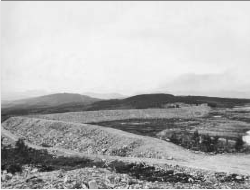
Torvehovdammen høsten 1953 etter at forsterkningene er gjennomført. (ØTBs arkiv)
