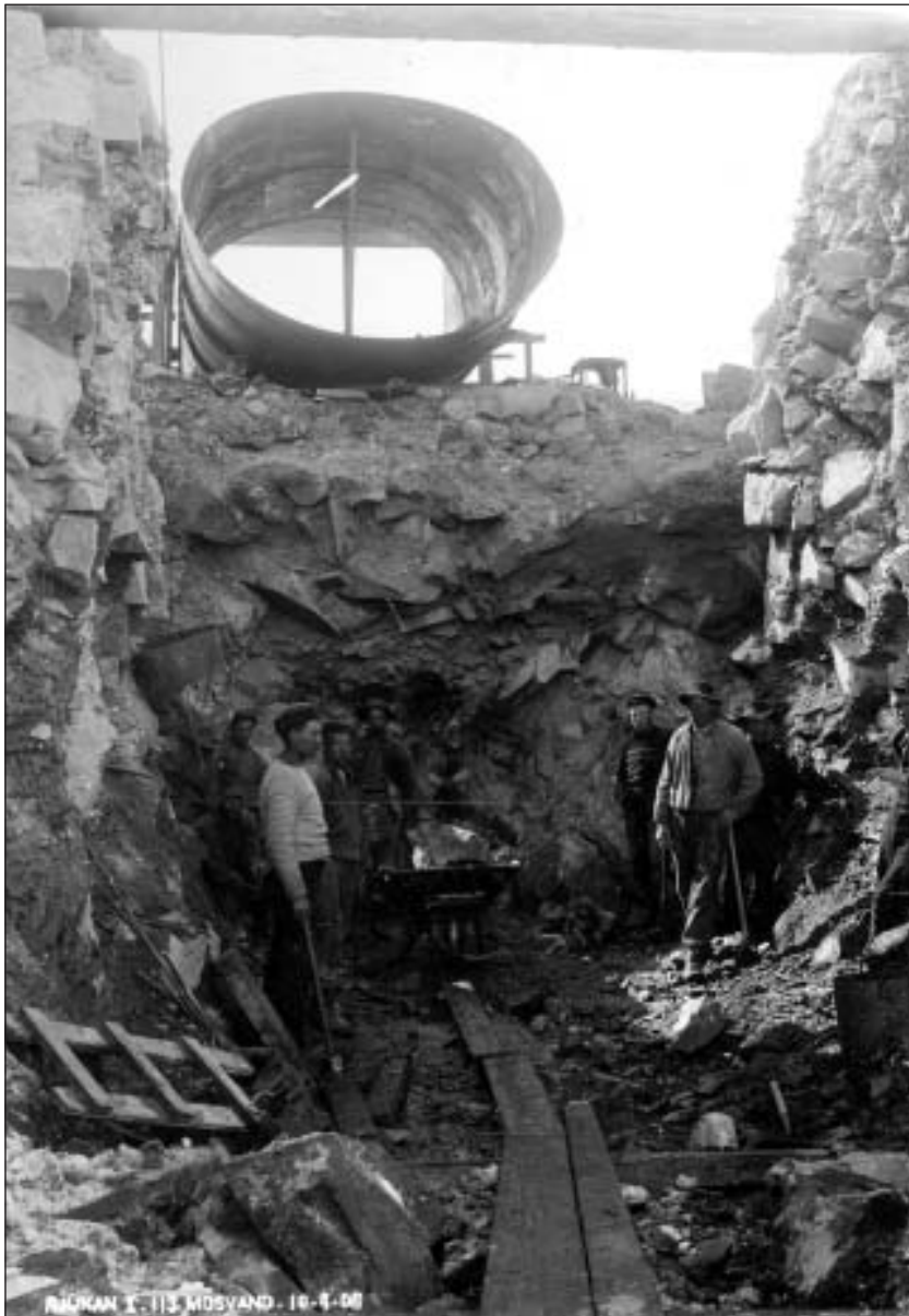
Et arbeidslag har kommet seg gjennom den gamle dammen 10.4.1908. (Hydros arkiv)
