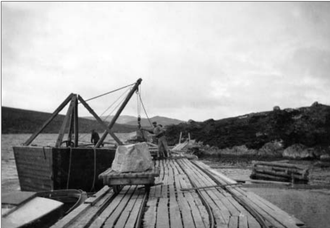
Lossing av steinlekter ved Kalhovdbrygga i oktober 1913. (Mår kraftverks arkiv)
