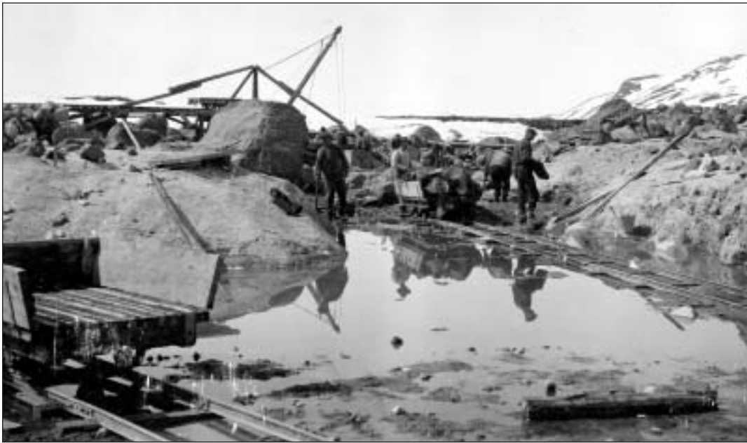
Tilløpskanalen på Kalhovde i mai 1912. (Mår kraftverks arkiv)
