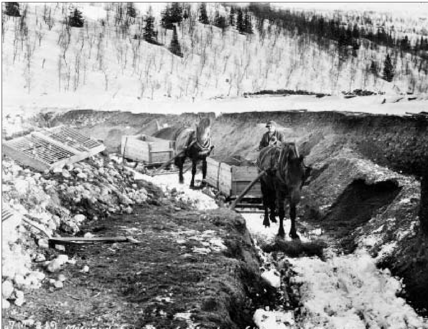
Hestekrefter i arbeid med sandkjøring til Møsvassdammen. 1905-1909. (Hydros arkiv)
