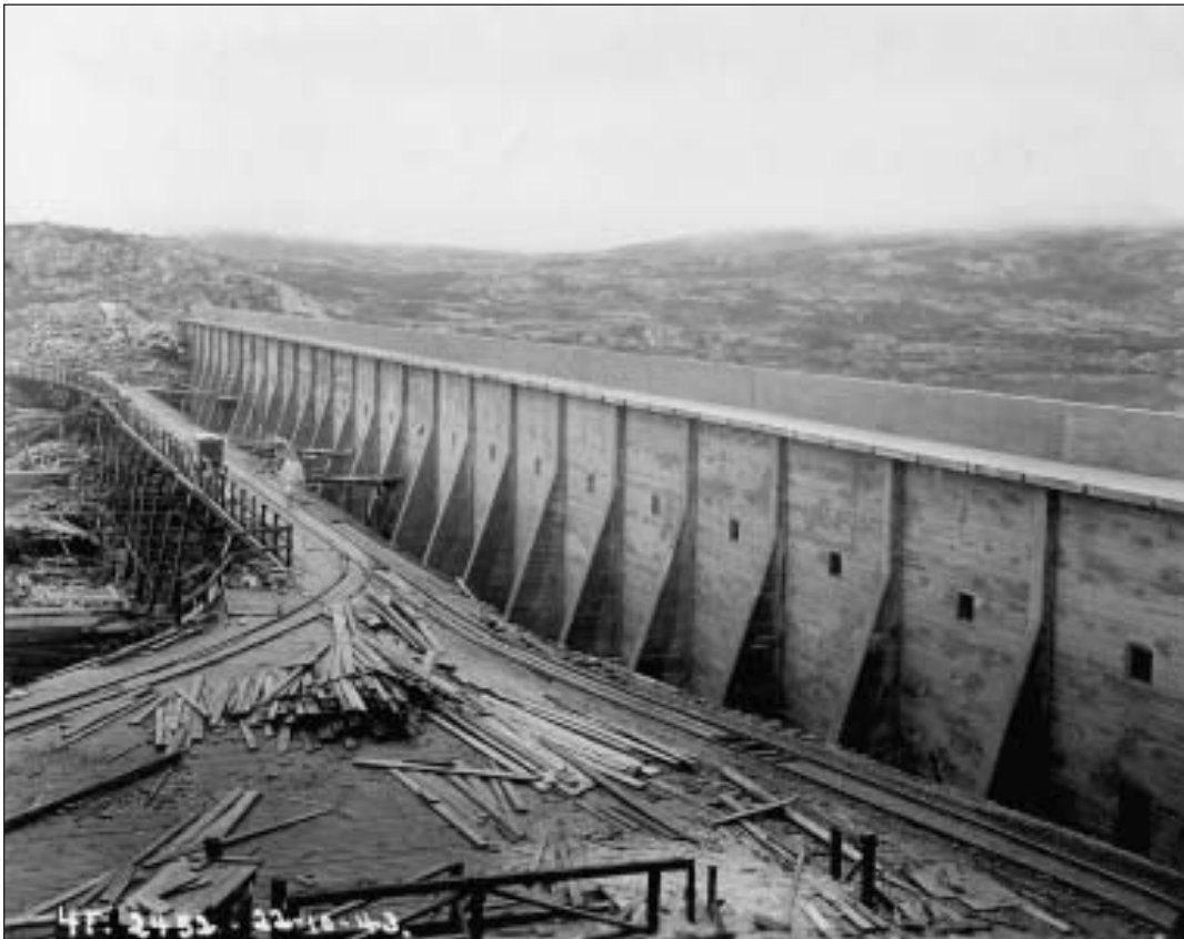
Strengedammen 22.10. 1943. Denne dammen består av tre deler med en samlet lengde på 640 m. Største høyde er 17 m. Dammen er utført med frontplate hvilende på pillarer og med isolasjonsvegg på luftsida. Størparten av støpesanden kom med tog til Rjukan og derfra til fjells med bil. (ØTBs arkiv)
