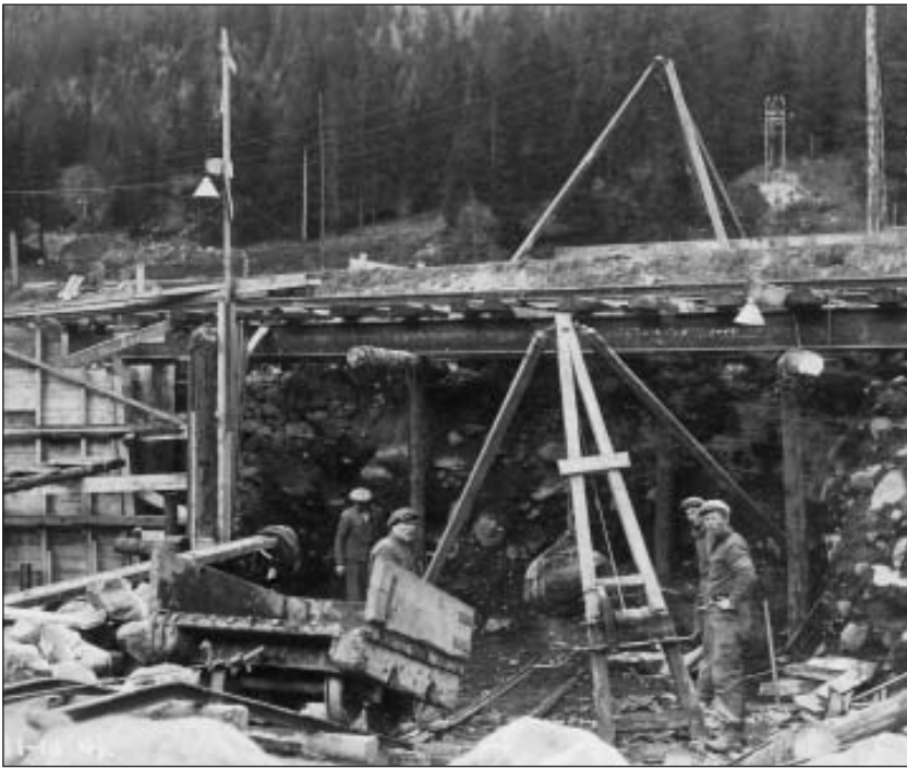
Utgraving for avløps-tunnel under jernbane og veg på Dale 14.10. 1941. (Mår kraftverks arkiv)
