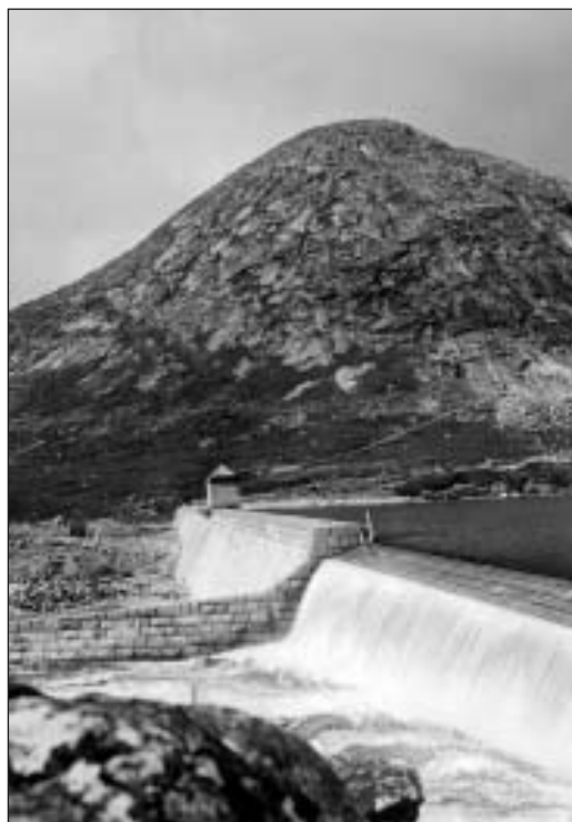
Mårdammen er en massivdam som er 210 m lang og har et overløp på 60 m. Dammen har to luker. I dag er dette den eneste dammen i ØTBs område som ikke er bygd om. (ØTBs arkiv)
