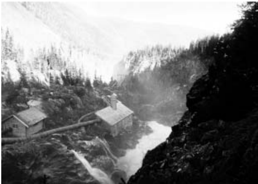
Bildet er fra Kvernhusfossen i Måna, 1911, og teksten sier at bygningen t.h. er Hydros aller første kraftstasjon. Det er kanskje mer riktig å si at det var den første i Vestfjorddalen, for Svelgfossen utenfor Notodden var utbygd i 1907. Bygningen t.v. er Hotell Rjukans «dynamohus» som ble brukt til å skaffe elektrisk lys til hotellet og til å flombelyse Rjukanfossen om kvelden. (Wilse/Norsk folkemuseum)
