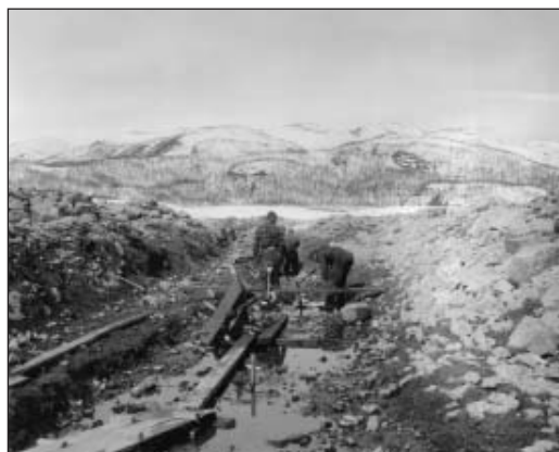
For å få størst mulig magasin i Møsvatn har det vært gravd en del kanaler for at det ikke skal stå igjen vann ved nedtapping. Her er det graving av kanal til Kromvatn i april 1941. (ØTBs arkiv)
